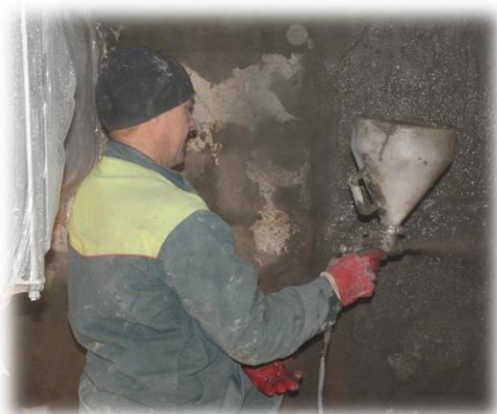
Рис. 2.1.7 Механический способ нанесения состава КАЛЬМАТРОН
