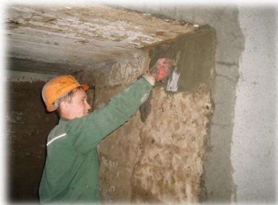
Рис. 2.1.8 Ручной способ нанесения состава КАЛЬМАТРОН
