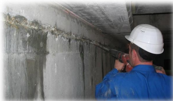
Рис. 2.1.4 Расшивка перфоратором «холодного шва бетонирования»
