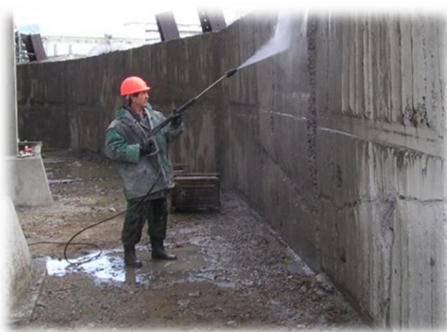
Рис. 2.1.3 Очистка и увлажнение поверхности гидромонитором
